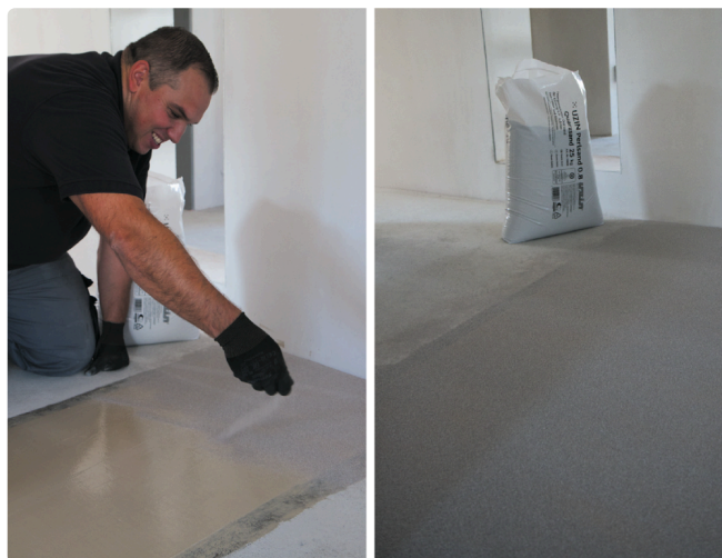
Перед последующими выравнивающими работами присыпать UZIN MK 92 S мелким песком UZIN Fine Sand слоем 0,8 мм.
