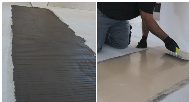
В зависимости от требований UZIN RR 203 можно применять с UZIN NC 182 или UZIN MK 92 S.
