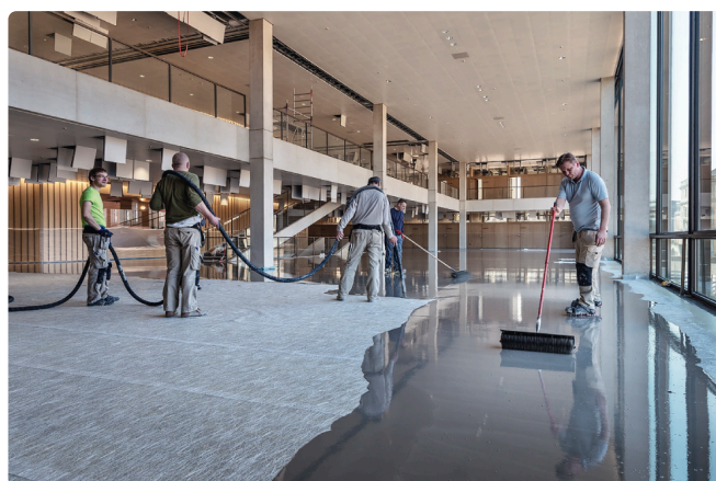
Подать насосом выравнивающий состав UZIN NC 160 поверх UZIN RR 201.
